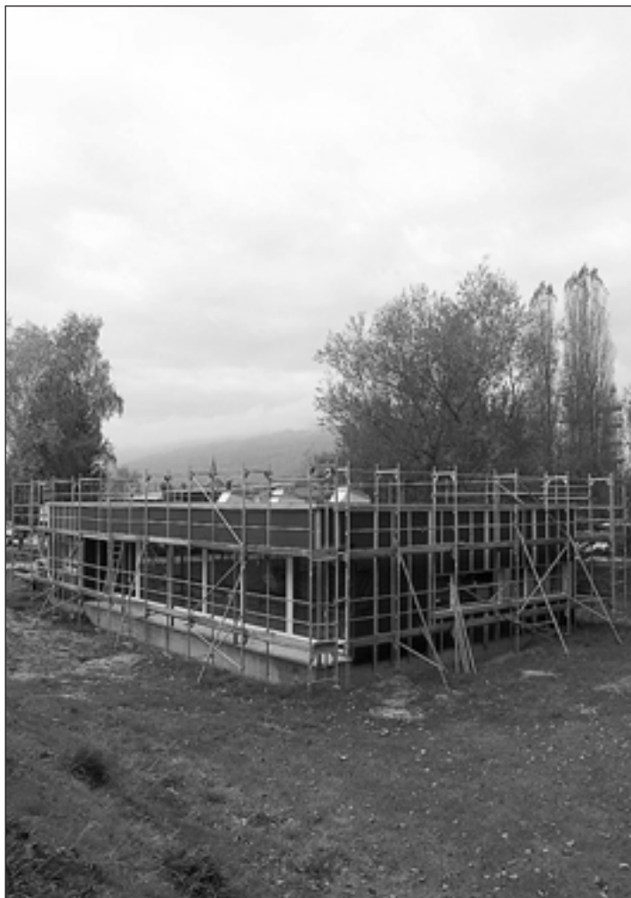
Sur le terrain des Français, le nouveau bâtiment est désormais érigé. Le revêtement des façades sera posé début novembre.
